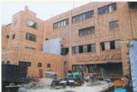
川島病院1号館西側改築工事
